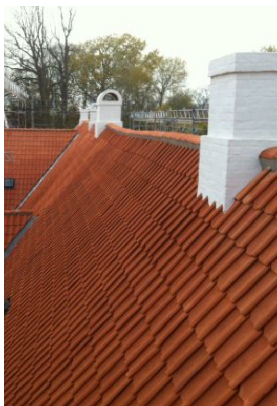
TAGOMLÆGNINGSPROCES, HVOR SKÆVHEDERNE OPRETHOLDES
